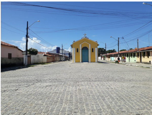
Foto 3 – Avenida São Sebastião, próximo à Capela São Sebastião – Trecho Final.
