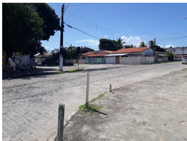
Foto 4 – Rua Juarez Távora – Trecho Final próximo a praça das Mães.
