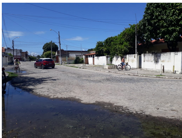
Foto 3 – Rua Juarez Távora – Trecho Final próximo a praça das Mães.
