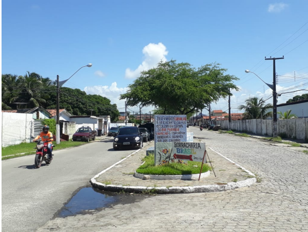
Foto 1 – Avenida São Sebastião, próximo ao Colégio Imaculada Conceição – Trecho Inicial.
